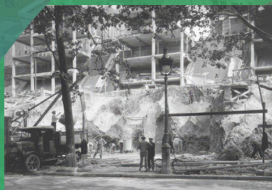
1904, l'hôpital en cours de construction.
