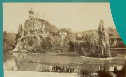
Le chantier du parc nécessita le concours de plus de 1 000 ouvriers, d'une centaine de chevaux et de 2 machines à vapeur (et plus de 39 kms de rails !)
